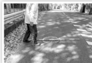
下水道施設の緊急点検 (マンホール周囲の段差や 沈下等を確認する様子)
