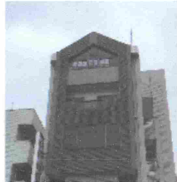
しんわグループ本社ビル
