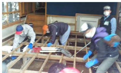
床下の泥出し作業
