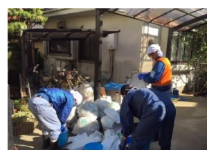
庭の泥出し作業
