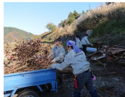
【第6陣】瓦礫の分別作業も重要
