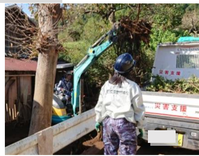
【第3陣】重機も入り本格的な作業へ
