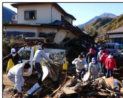
【第6陣】倒壊寸前の住宅前で作業
