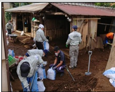
【第2陣】物置流入の土砂撤去作業
