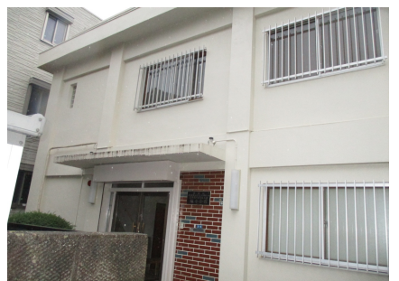
大和中央5丁目にある組合会館
